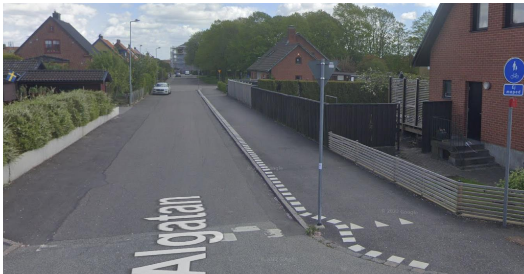
Figur 3-4. Exempel på typisk cykelinfrastruktur i Svedala. Kombinerad gång- och cykelväg på breddad trottoar
