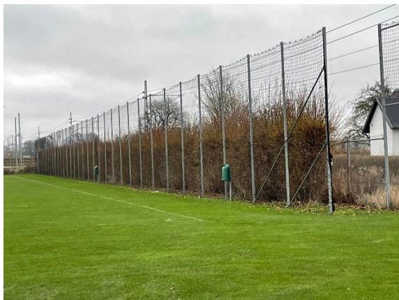
Häckar utmed järnväg.
