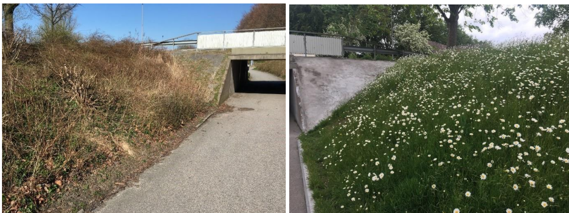
Gång- och cykeltunnel vid Kapellvägen i Svedala före och efter genomförd åtgärd
