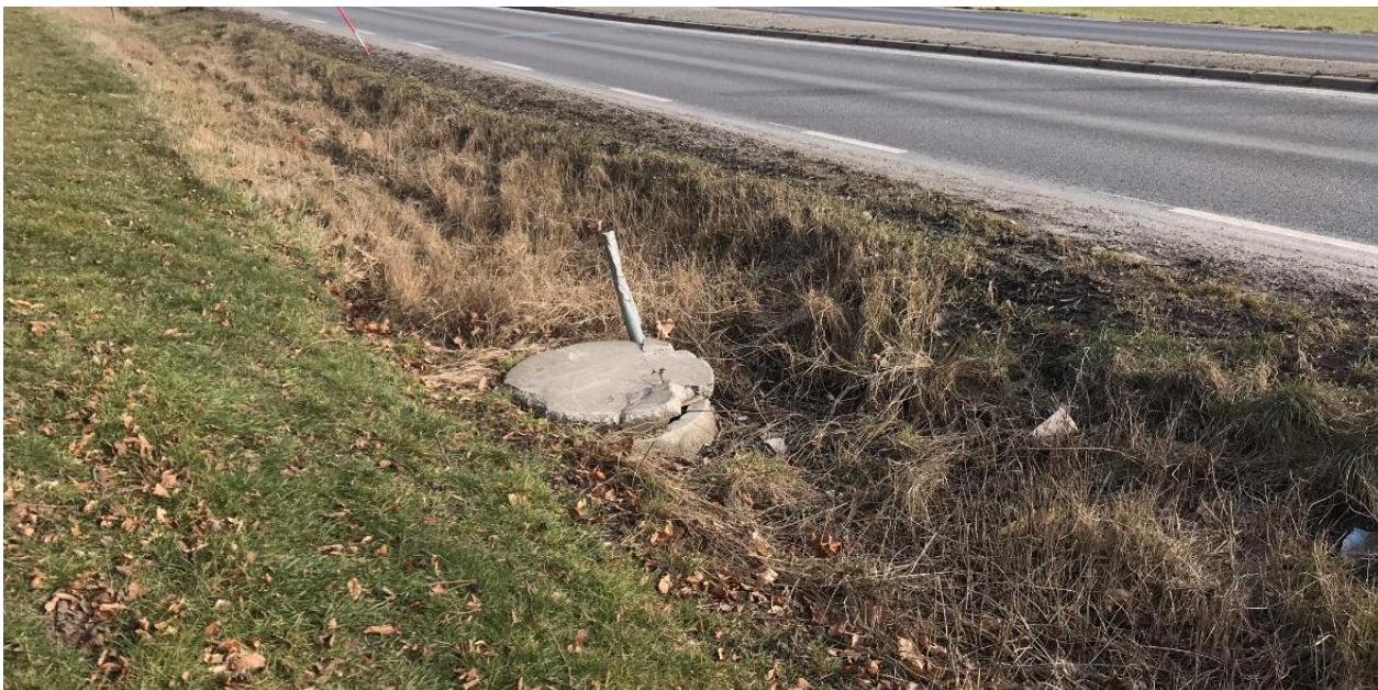
Figur 9. Befintlig brunn intill Malmövägen observerad vid platsbesök
