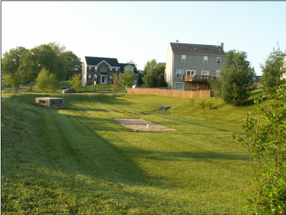
Figur 20. Exempel på nedsänkt yta för dagvattenhantering (Montgomery county, 2021)
