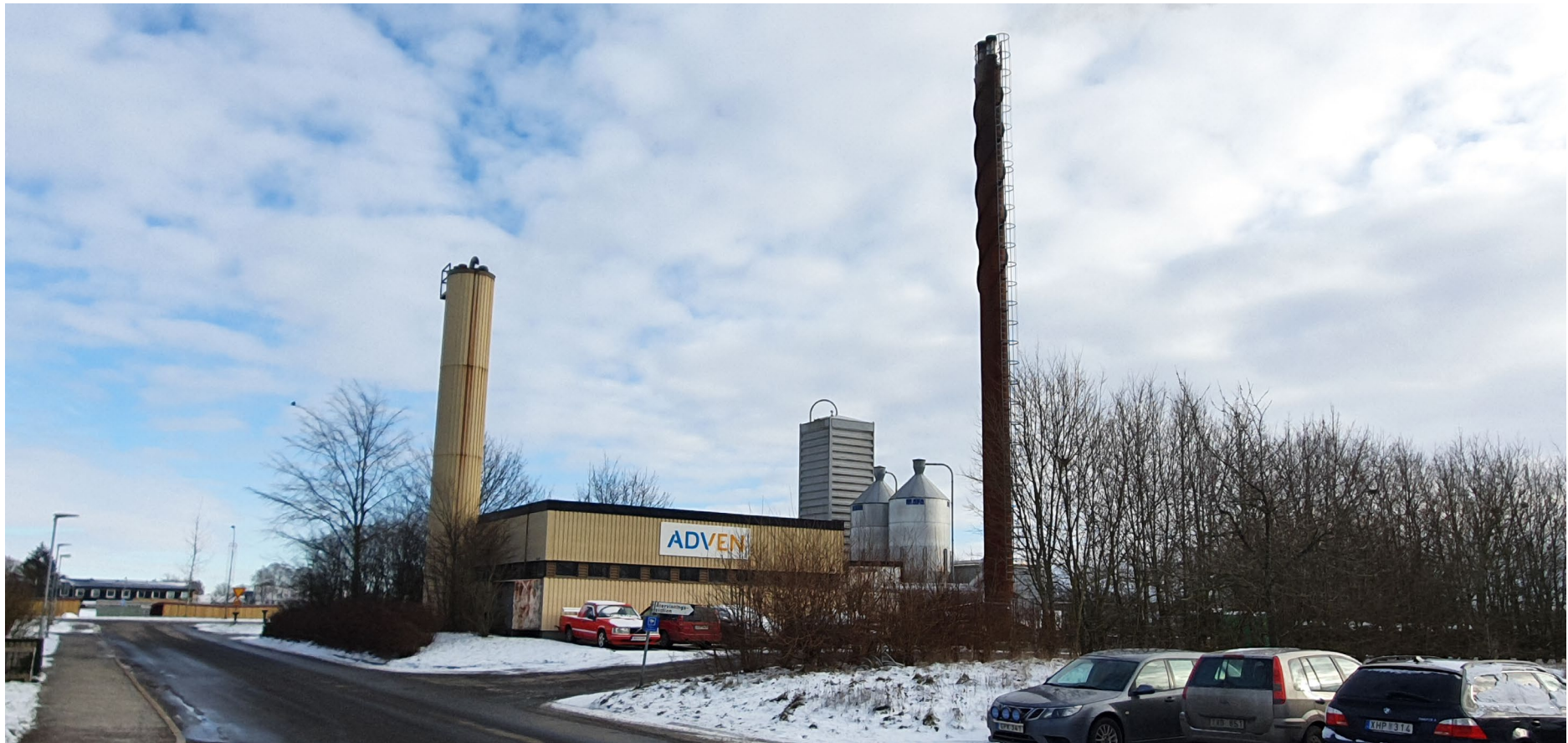
4. Fjärrvärmeverket med träridåer och buskage, sett från Centrumgatan mot öster.
