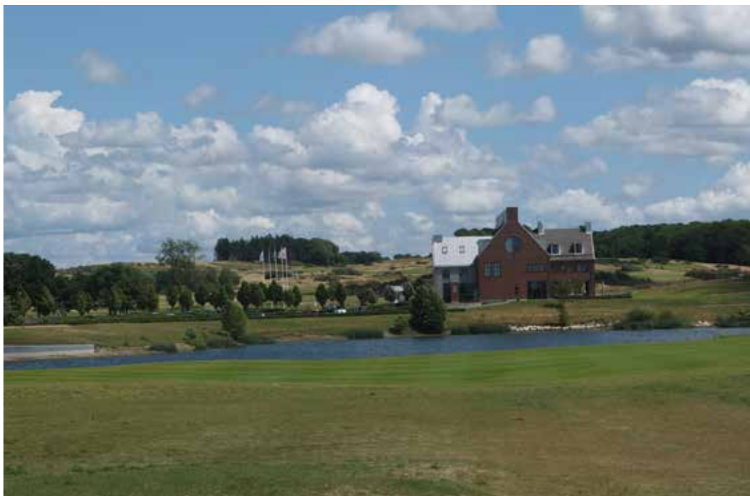
Vy över golfbanan med huvudbyggnaden från väster.
