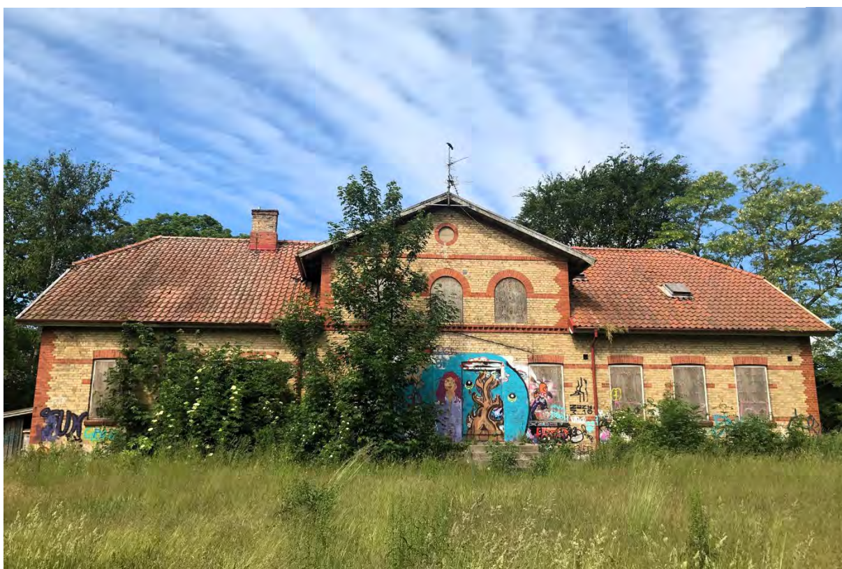
Figur 29. Bild över östra fasaden för Spångholmens mangårdsbyggnad från början av 1900-talet som brann ner 2022.
