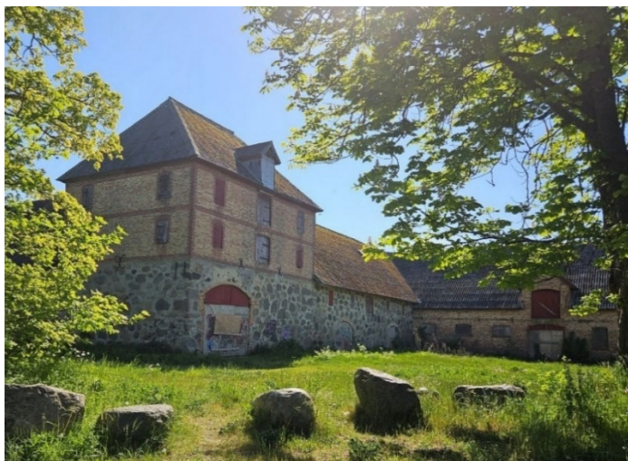
Figur 6. Byggnaden har på flera håll blivit utsatt för vandalisering och klotter. Foto. Projektbyggaren Teknik Syd AB.
