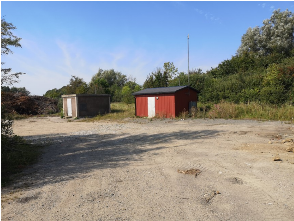
Upplag i nordost med pumpstation (i rött) och nätstation (i grått)
