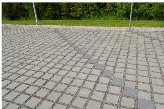
Figur 5. Genomsläpplig yta - användning av allmän platsmark för infiltration av dagvatten. Foto från Svedala.
