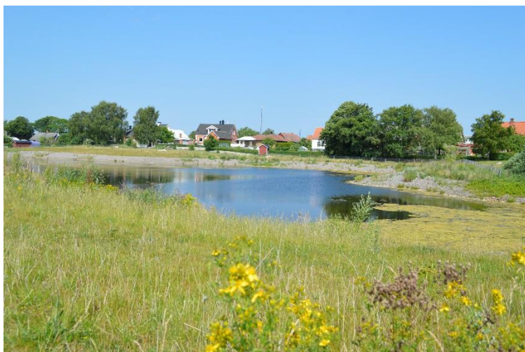
Figur 7. Exempel på samlad fördröjning i en damm. Foto från Östra industriområdet, Svedala.
