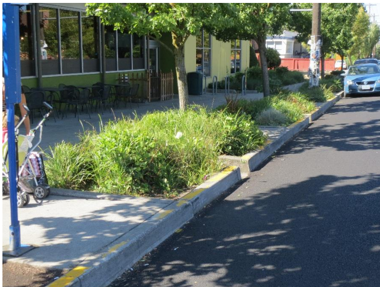
Figur 1. Regnbäddar är växtbäddar som samlar vatten från gator och andra hårdgjorda ytor. Dessa växtbäddar anläggs för att avlasta dagvattensystemet och för att rena dagvatten. Foto från Portland.
