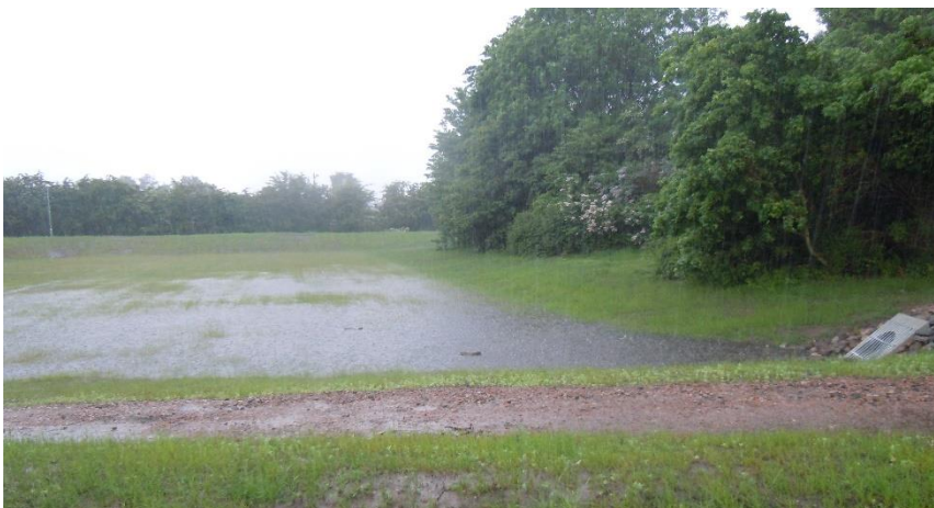
Figur 11. Användning av invallad fotbollsplan för utjämning av dagvatten vid stora regn i Vellinge kommun. Foto: Carl Nelin
