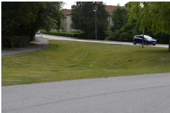
Figur 10. Exempel på grönyta i gaturummet som kan användas som översvämningsyta vid extrema regn. Foto från Kyrkogatan, Svedala.
