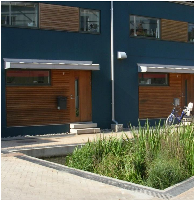
Figur 2. Takavvattning till damm. Foto från Västra Hamnen i Malmö.
