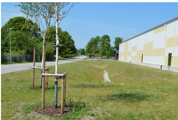
Figur 6. Dike för avledning av dagvatten. Foto från tennishallen, Svedala.
