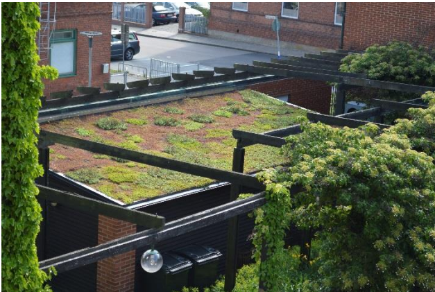
Figur 3. Exempel på grönt tak. Här är avdunstningen stor och vattnet fördröjs. Foto från Svedala kommunhus.
