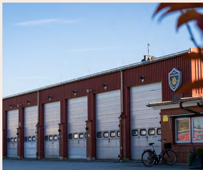
Brandstationen i Svedala.
