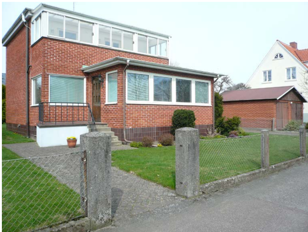
Stängsel, kantstöd och grindstolpar är bygglovsbefriade, Svedala
