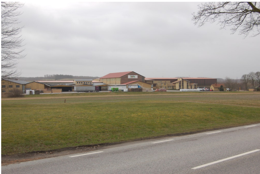
Figur 17. Bara Mineral på Malmövägen 63:1.
