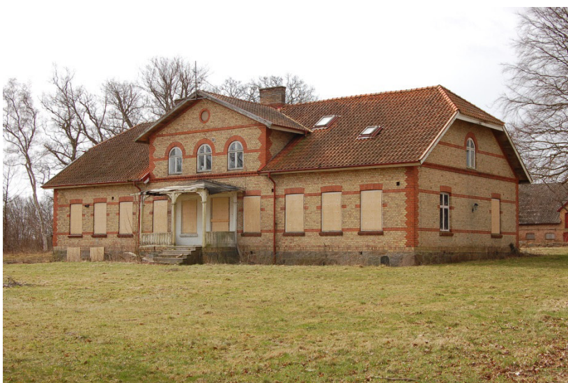
Figur 23. Corps de Logi vid Spångholmens gård. Objekt nr. 100 i tabell 1.
