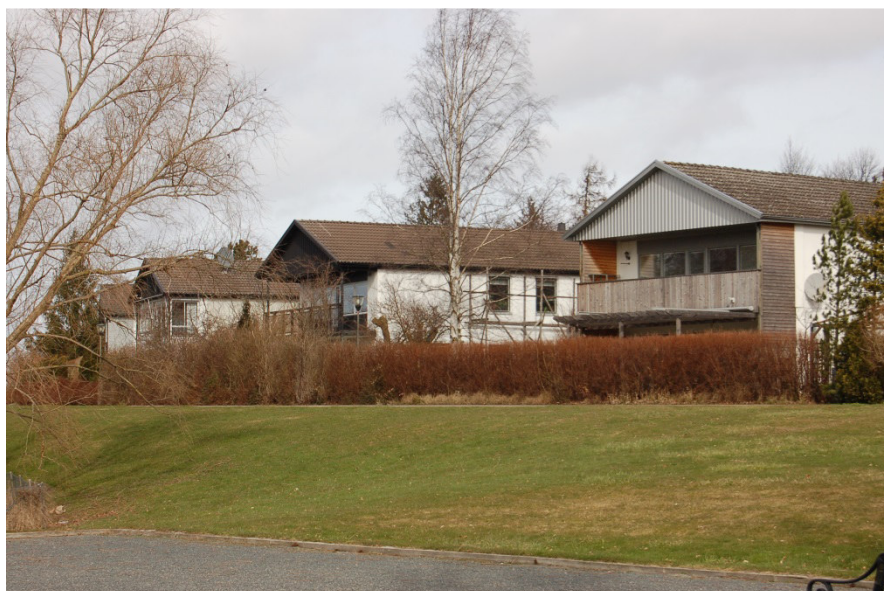
Figur 30. Sutteränghus med "alphyttekaraktär" på Henriette Coyetts gata.
