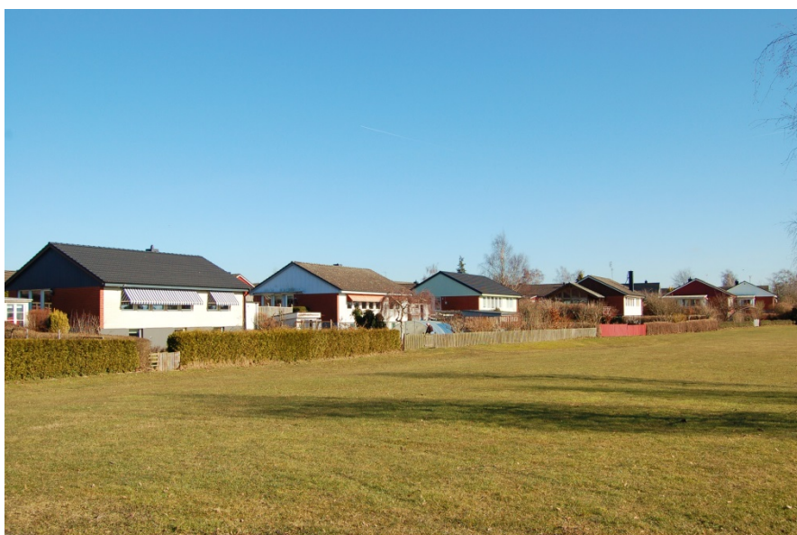
Figur 33. Borehus på Aprikosgatan (från trädgårdssidan)
