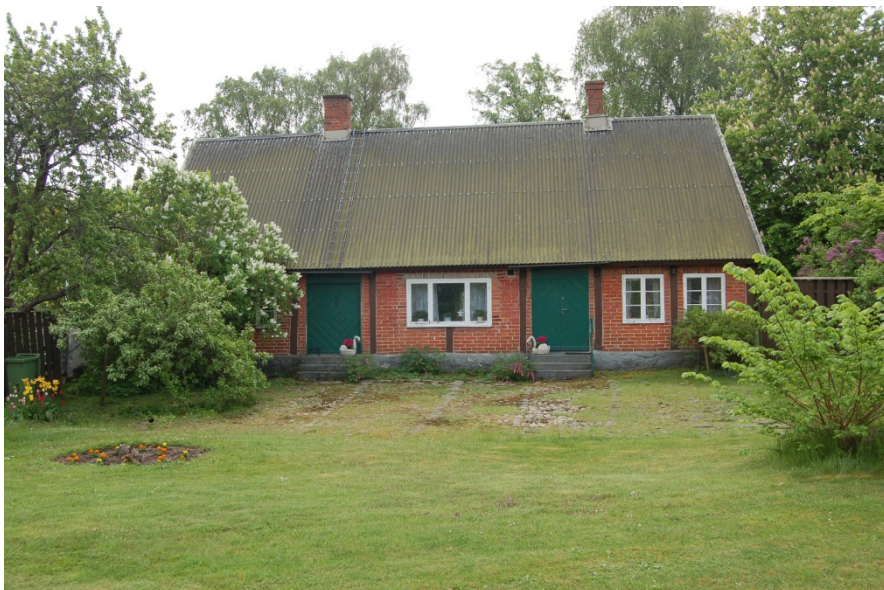
Figur 21. Hus på Skomakaregatan 5. Objekt nr 24 i tabell 2
