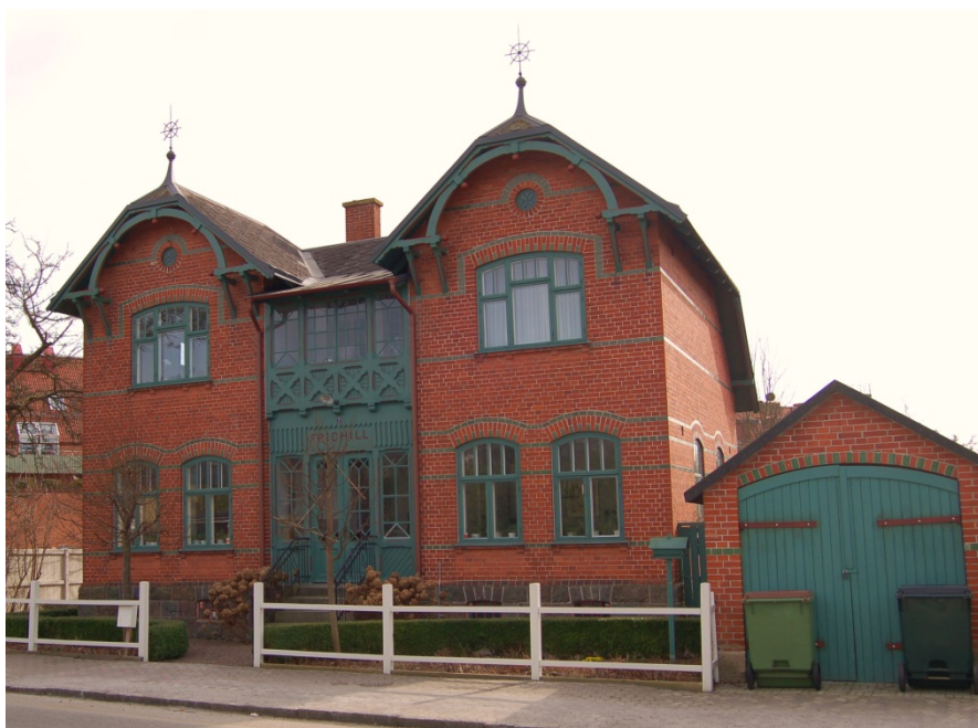
Figur 25. Hus på Almgatan 7. Objekt nr 25 i tabell 1
