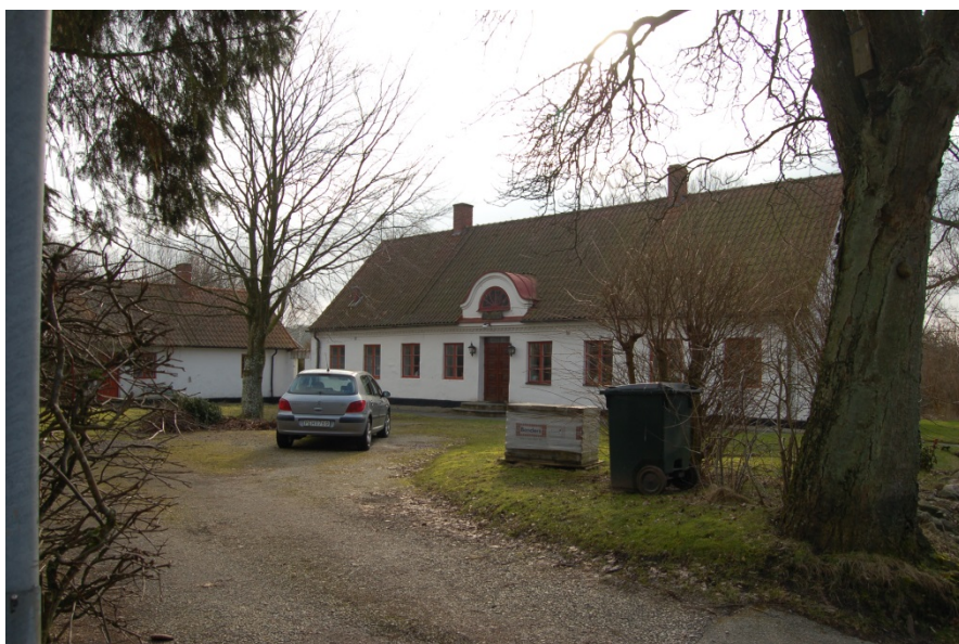
Figur 19. Grecosborgsgatan 4. Objekt nr 1 i tabell 5
