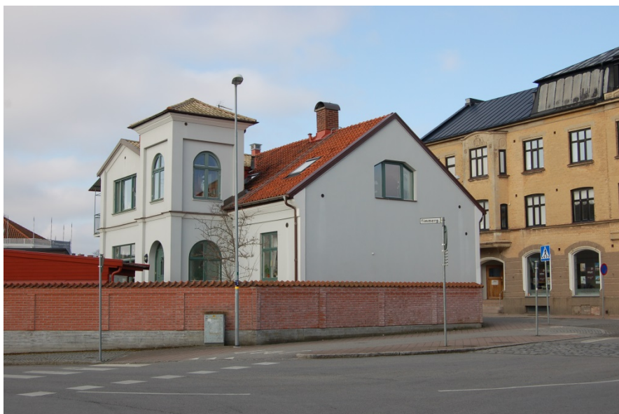
Figur 26. Hus på Storgatan 8. Objekt 7 i tabell 1
