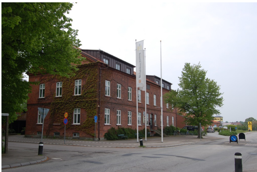
Figur 10. Nils Fredrikssons gymnasieskola. Objekt nr 2 i tabell 3
